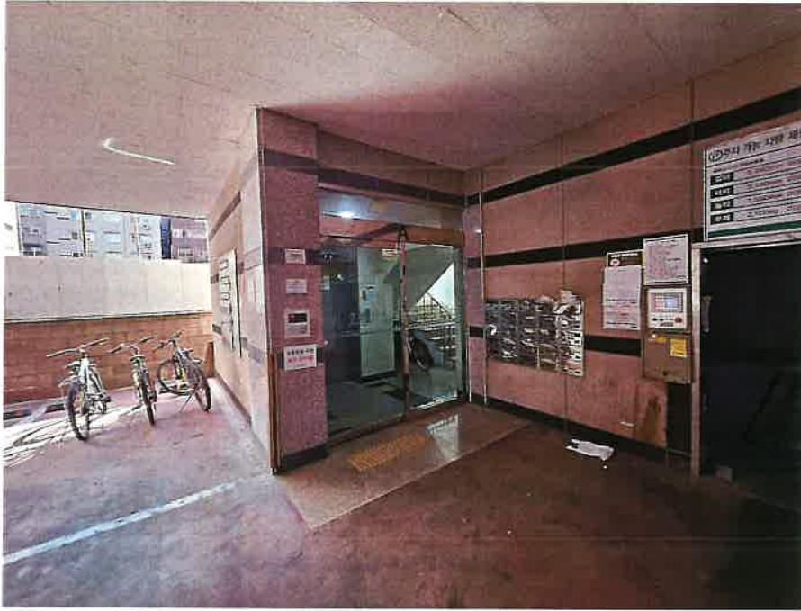
본건 주출입구 전경
