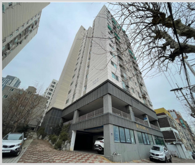
본건 소재 건물 전경 (북서측)
