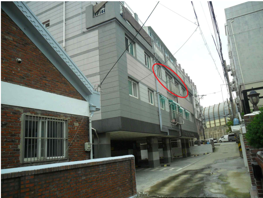
대상물건 전경 (남동측에서 촬영)
