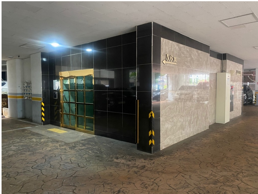
1층 출입구 전경
