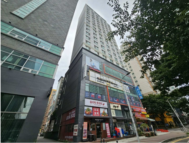
[본건 전경] 본건 남서측에서 촬영
