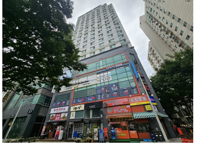
[본건 전경] 본건 남측에서 촬영
