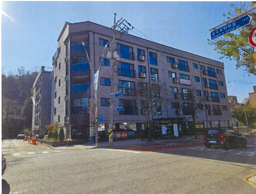
본건 건물 전경
