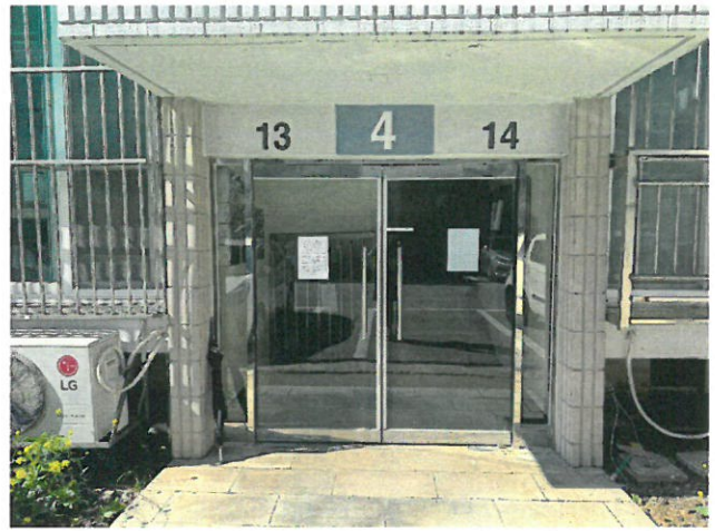
본건 기호 (나) 공동현관문 전경
