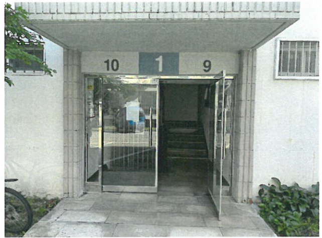
본건 기호 (다) 공동현관문 전경
