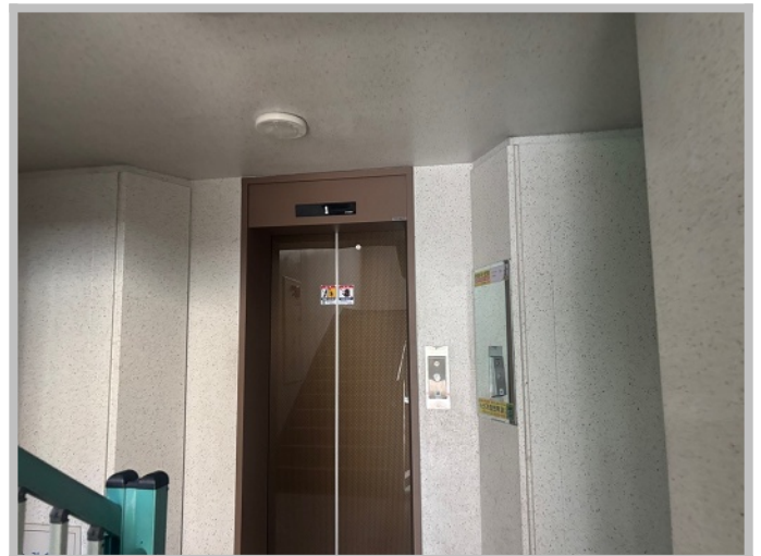
【 본건 승강기 설비 전경 】
