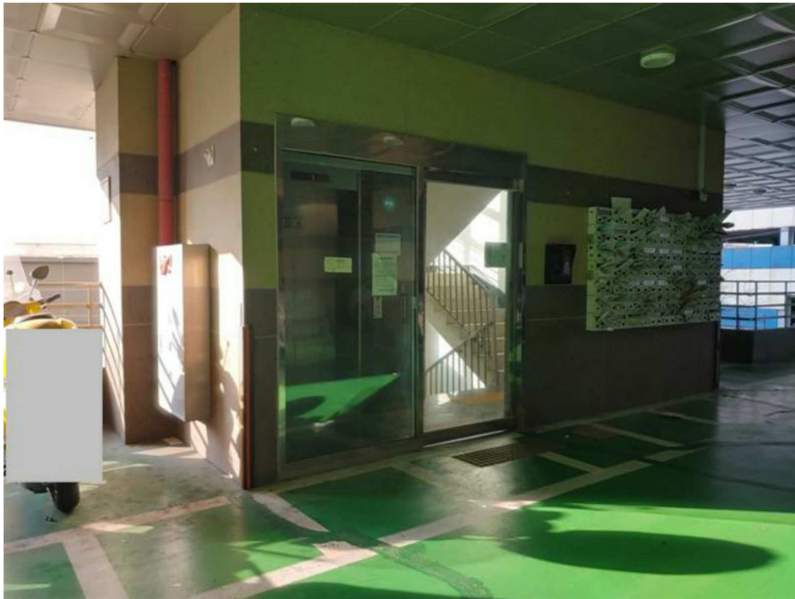
1층 공용출입구 전경
