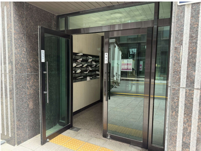
본건 소재 건물 출입구 전경
