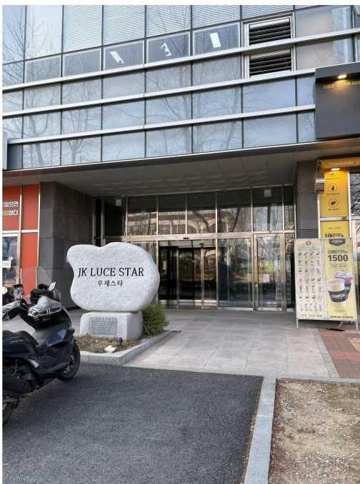
본건 1층 출입문
