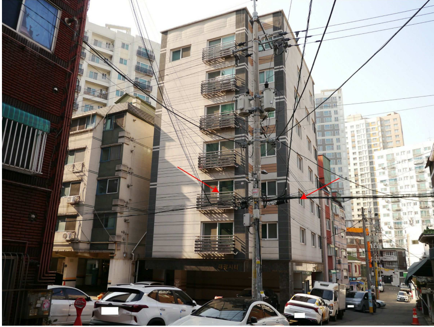
본건(대광시티 3층 301호) 전경(남동측에서 촬영)
