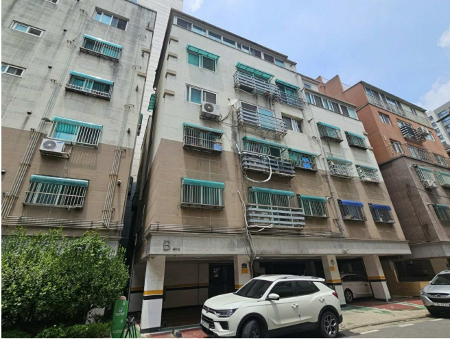
[본건 전경] 본건 남측에서 촬영
