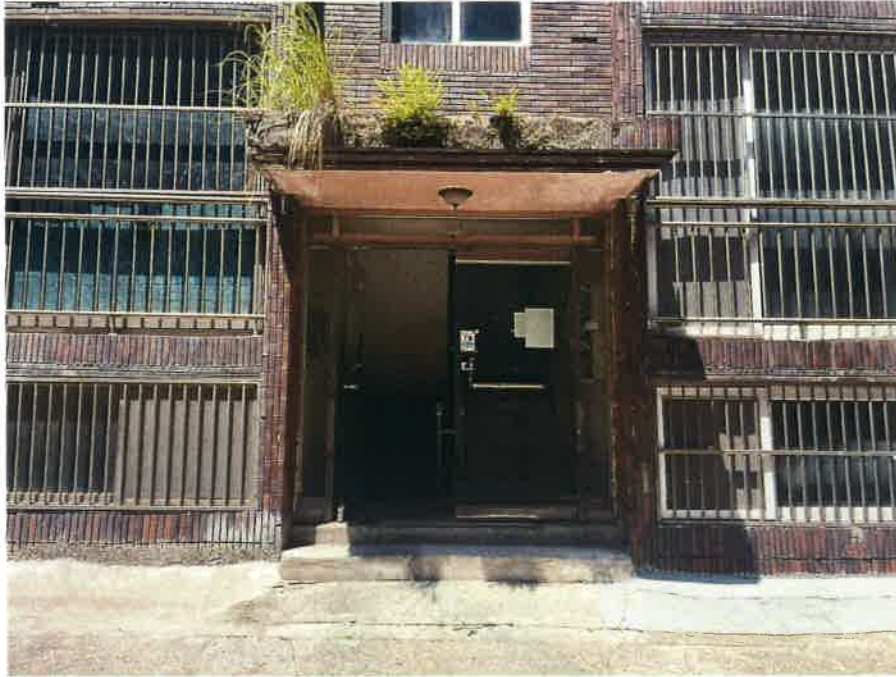
본건 1층 공동현관문
