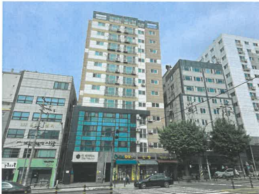
본건 건물 전체 전경
