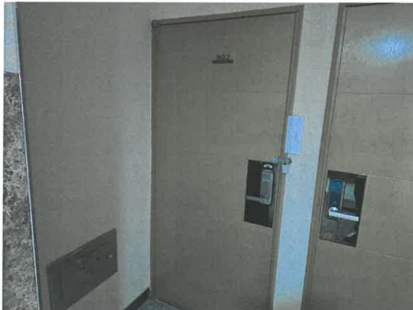
본건 출입문 전경
