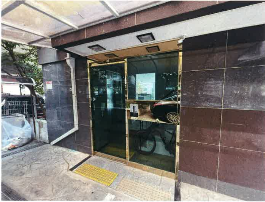
본건 1층 공동현관문
