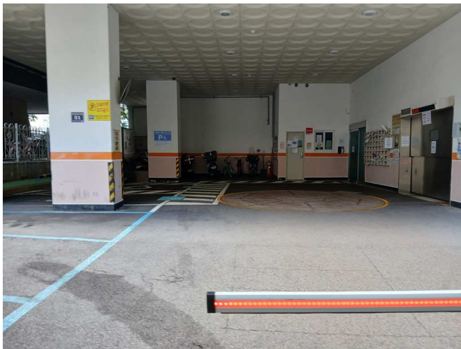
본건 추자장및 공동출입구
