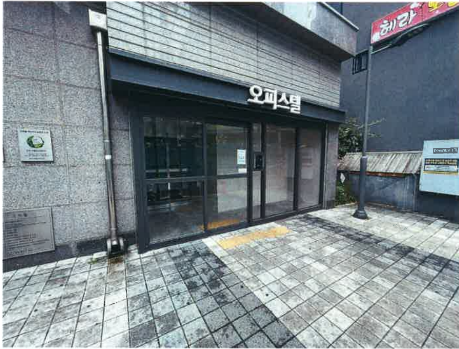
본건 1층 공동현관문
