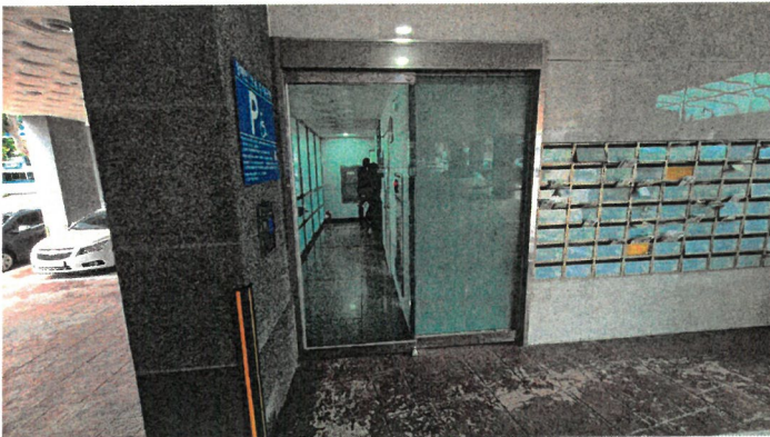
본건 1층 출입구
