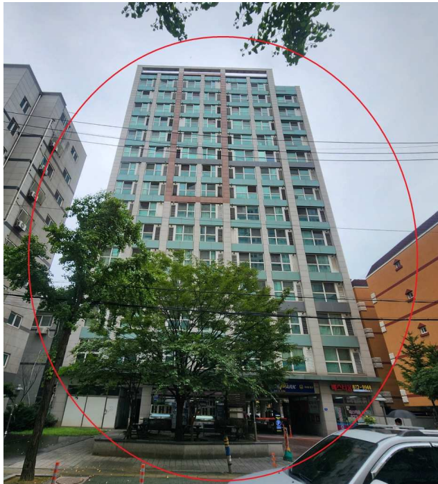
건물 전면부 전경(본건 남측에서 촬영)
