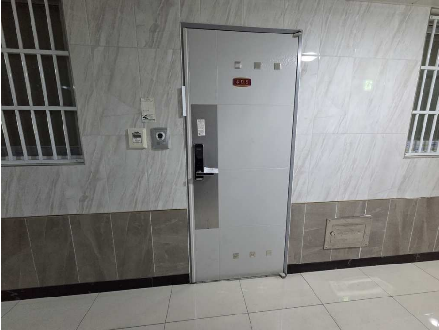
본건 현관문 전경
