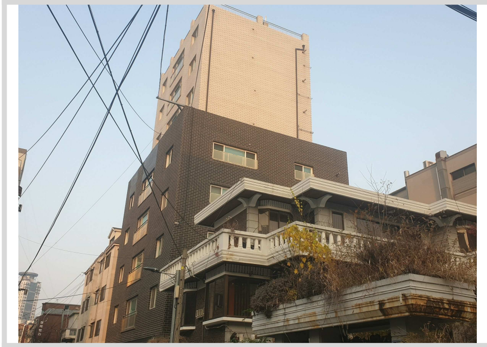
건물 남측 전경
