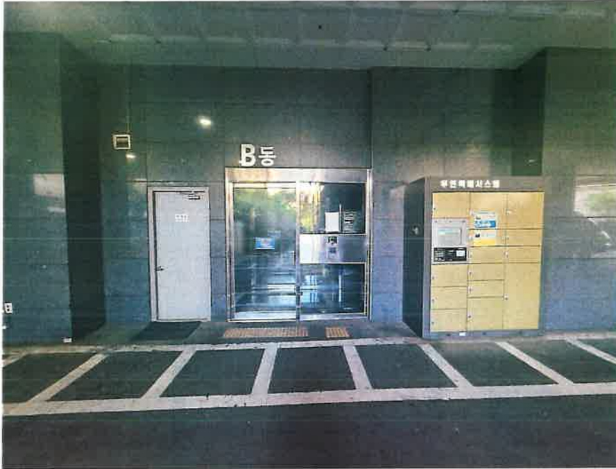
본건 주출입구 전경
