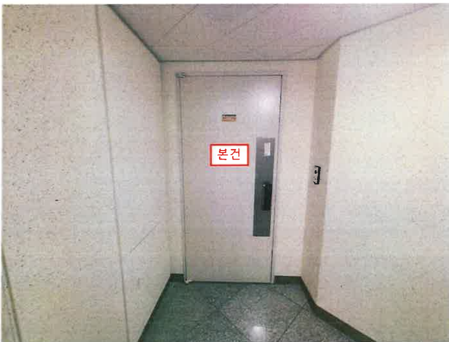
본건 현관문 전경
