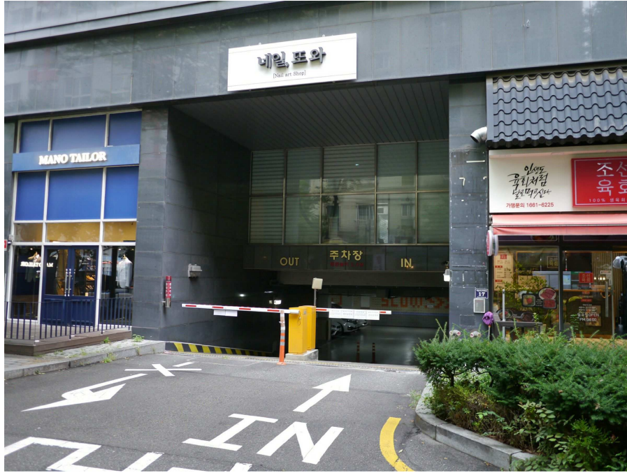
본건 단지 지하주차장 출입구
