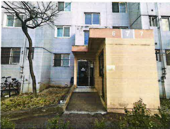
본건 공동현관 출입구 전경
