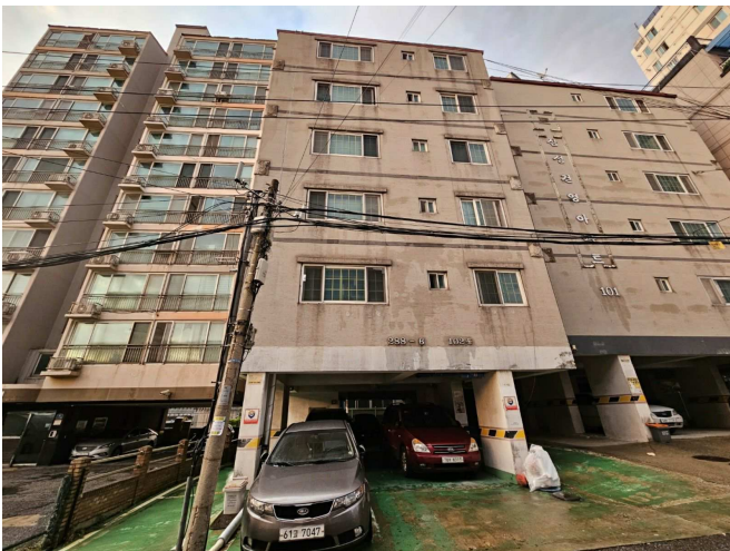
[본건 전경] 본건 남측에서 촬영
