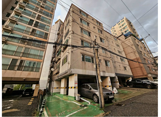
[본건 전경] 본건 남서측에서 촬영
