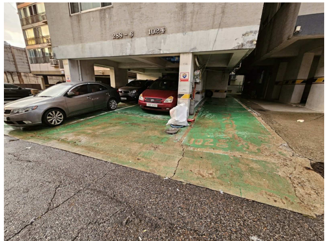
[본건 전면 출입구]
