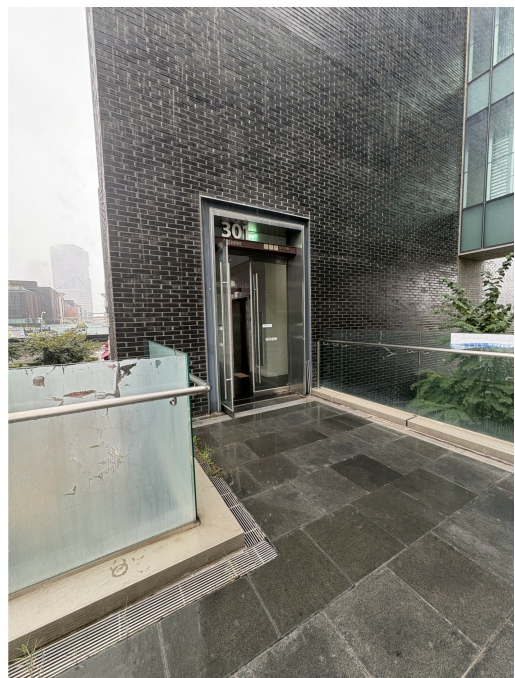
본건 1층 출입구
