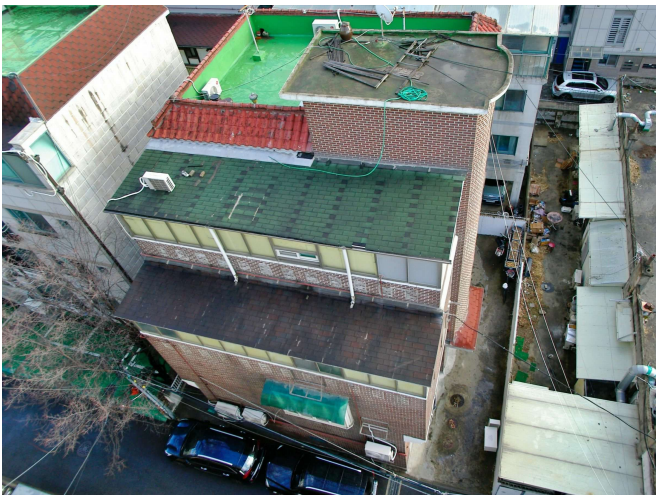
대상건물 전경(북측, 옥탑)
