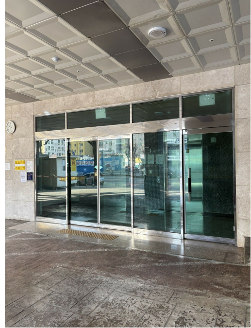
본건 1층 출입구
