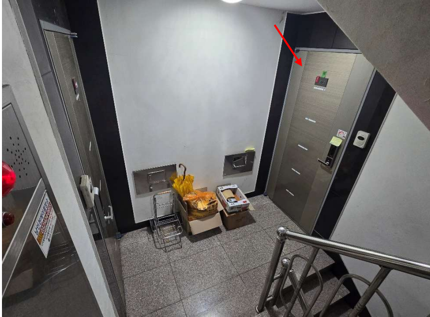
대상물건의 복도 사진
