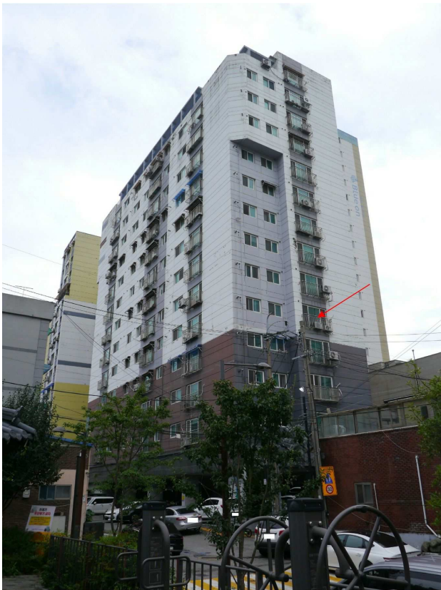
본건(코지팰리스 5층 501호) 모습(북서측에서 촬영)
