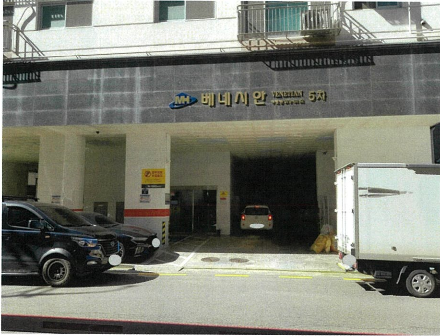
본건 소재 건물 1층 출입구 전경
