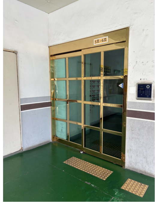
본건 1층 출입구
