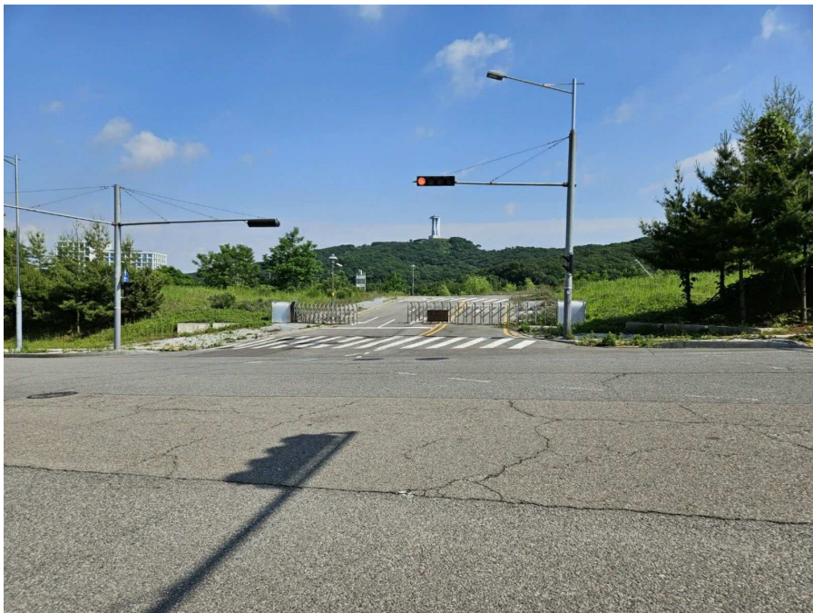
[본건 전경]<기호4> 본건 북서측에서 촬영
