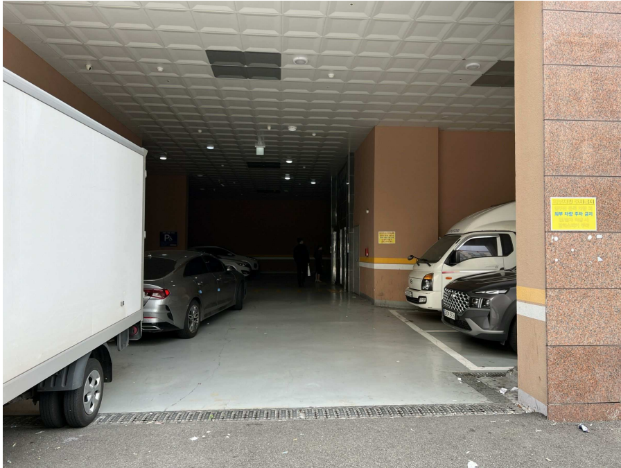
지하층 출입부 및 주차장 부분
