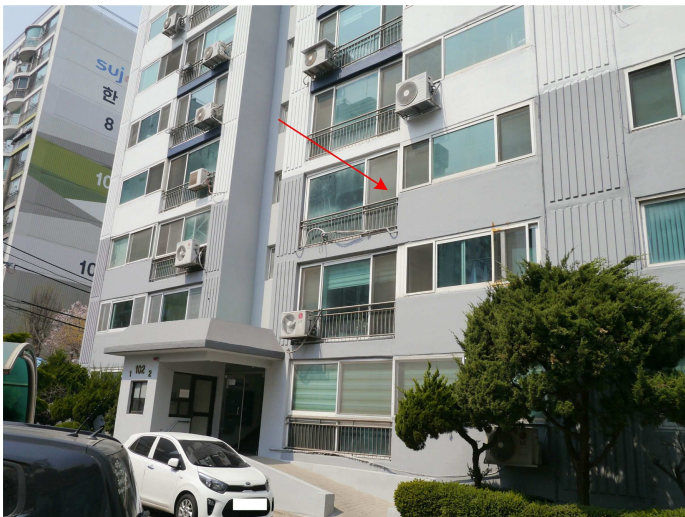
본건(뉴서울아파트 2동 3층 302호) 외부 모습
