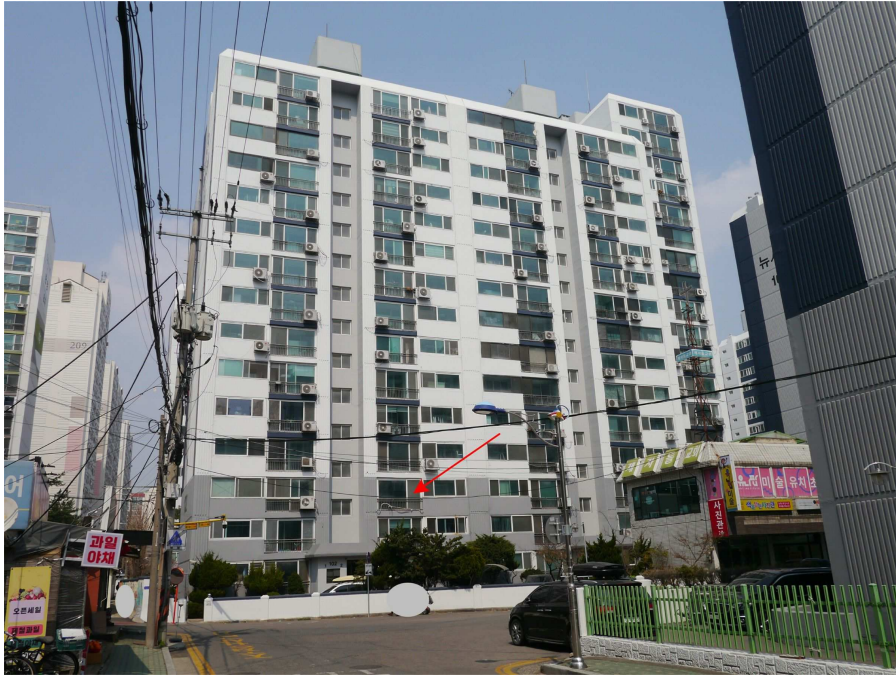
본건(뉴서울아파트 2동 3층 302호) 모습(남측에서 촬영)
