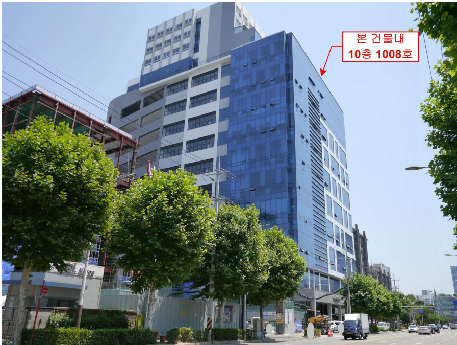
부평테크노파크엠2 전경(남서측에서 촬영)
