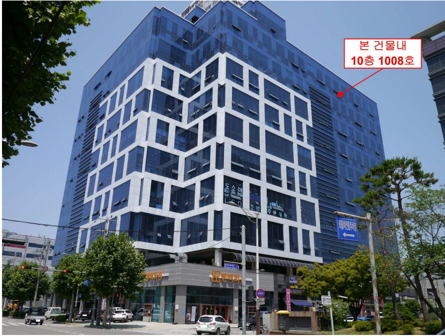
본건(부평테크노파크엠2 10층 1008호) 전경
