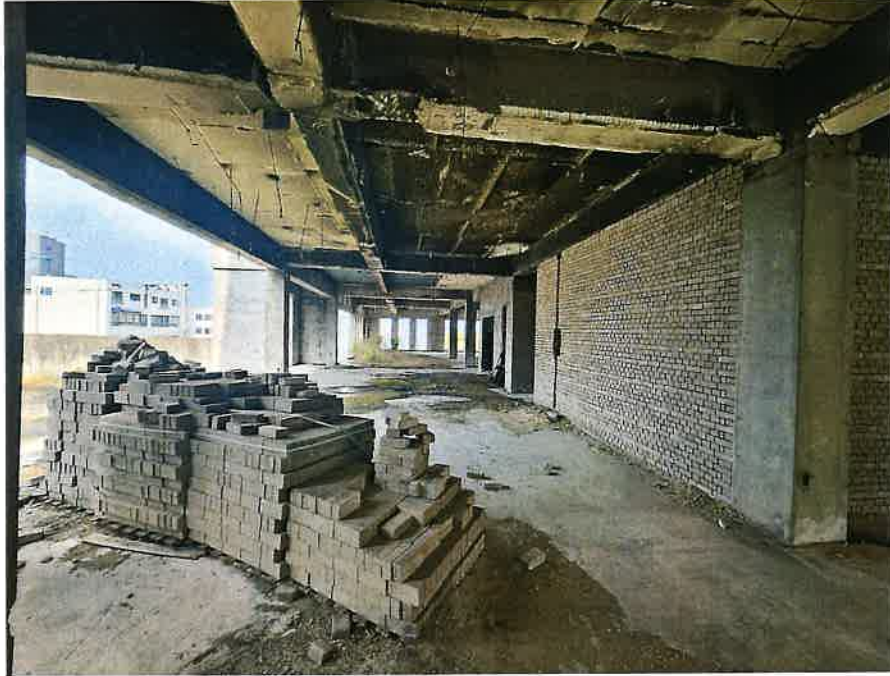
본건 건물 3층 내부전경
