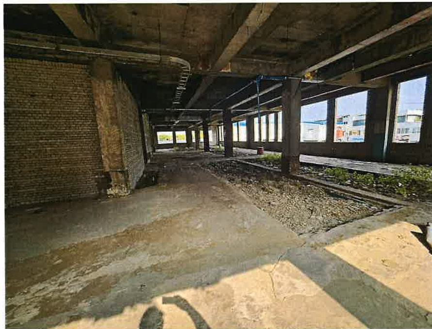
본건 건물 2층 내부전경
