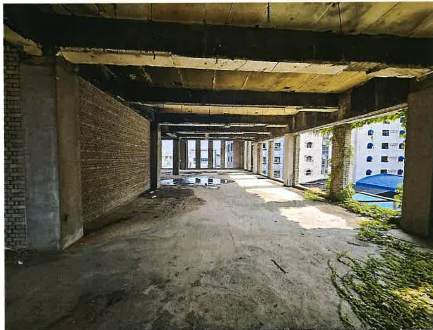
본건 건물 3층 내부전경
