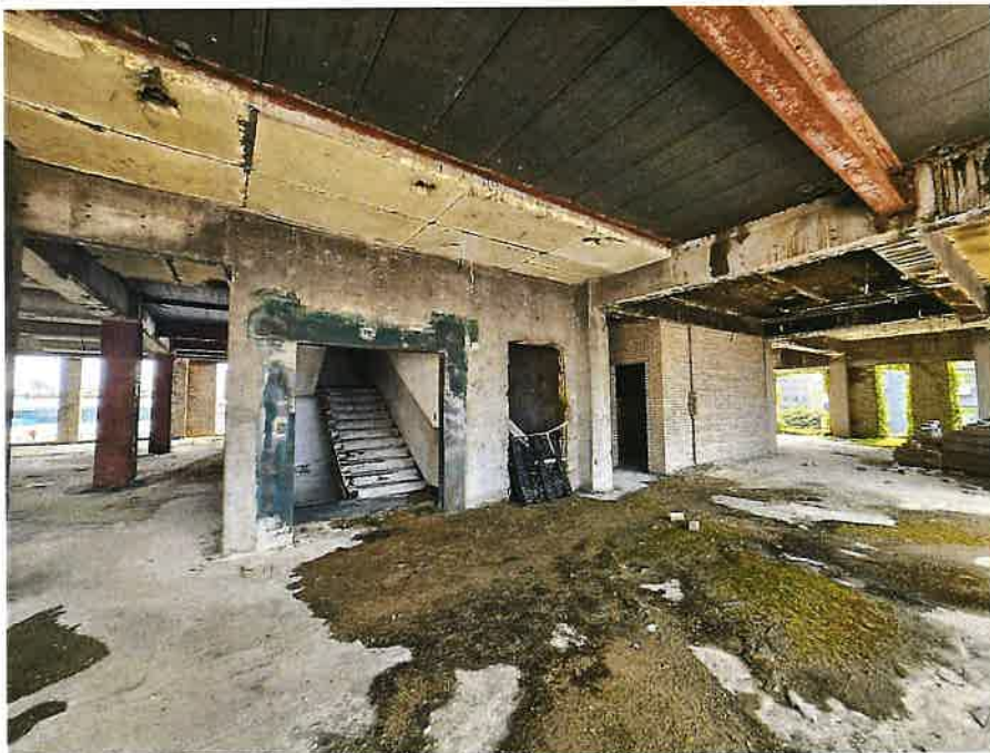
본건 건물 3층 내부전경
