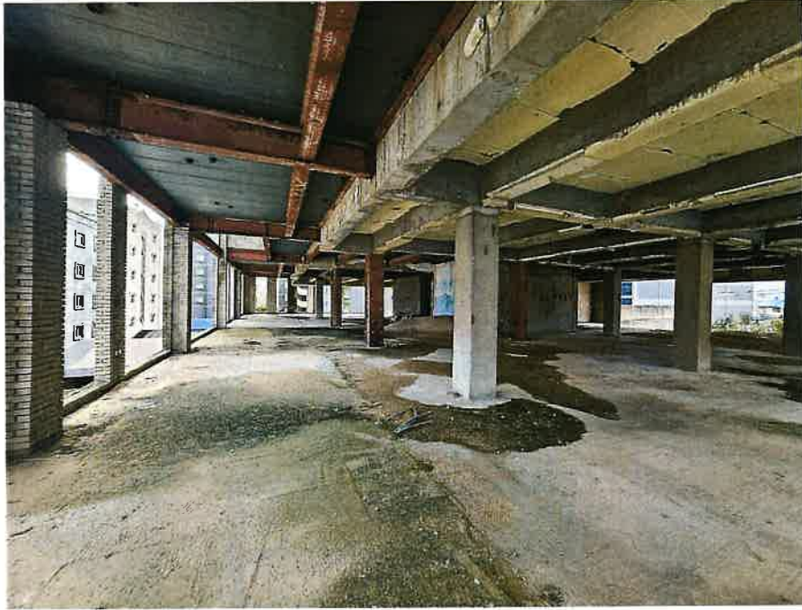
본건 건물 3층 내부전경
