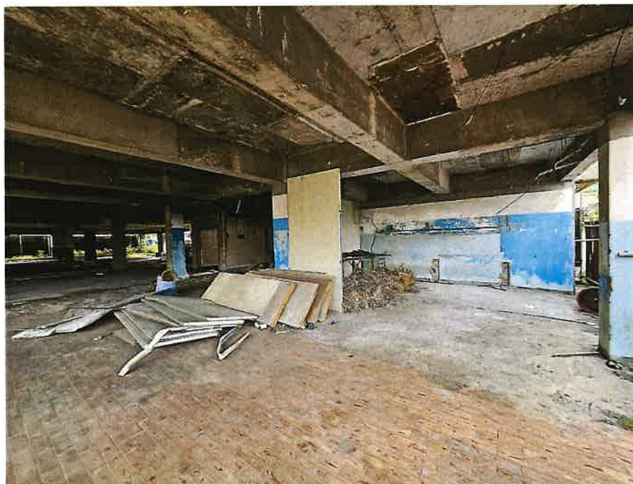
본건 건물 1층 내부전경
