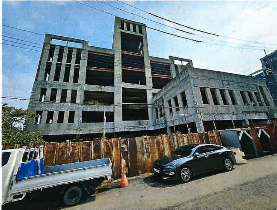
본건 건물 전면부 전경
