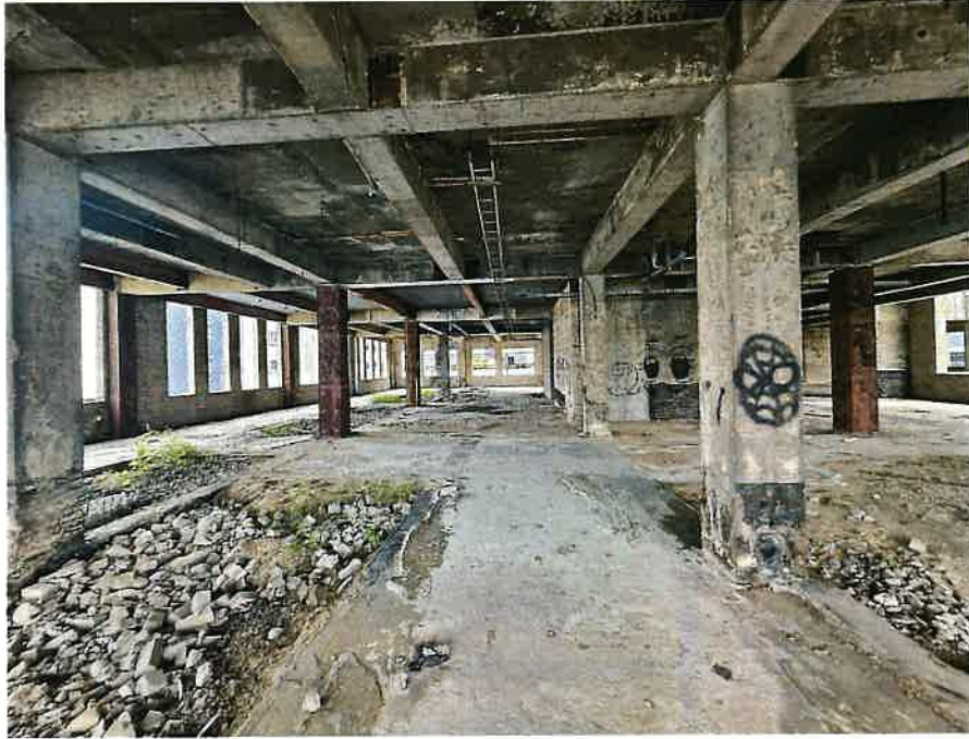
본건 건물 2층 내부전경
