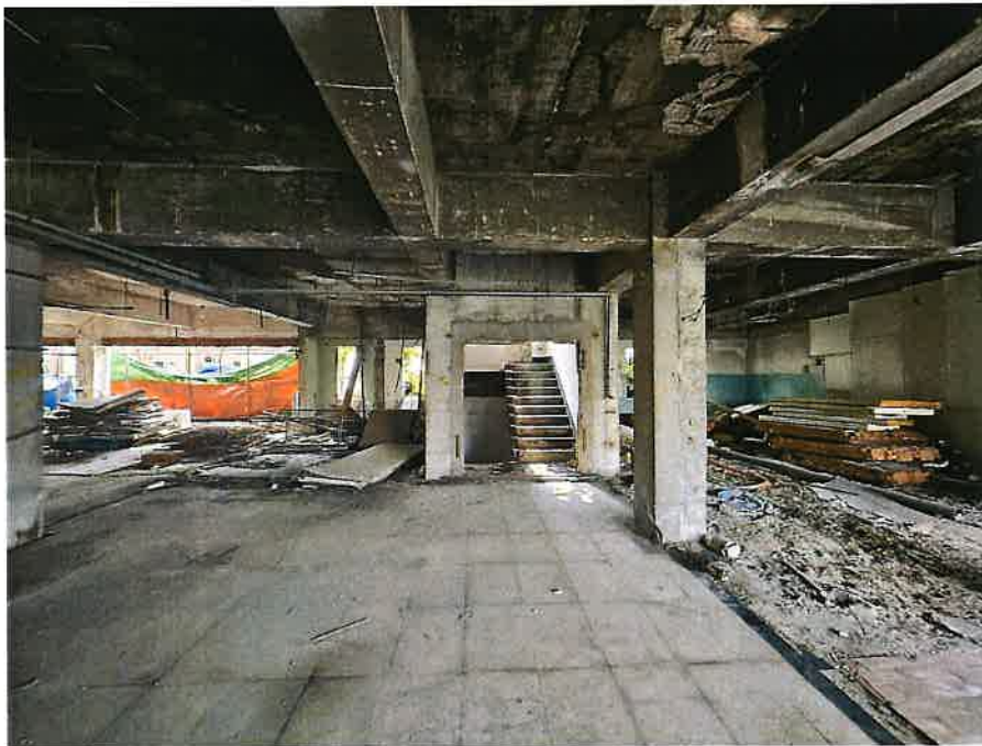
본건 건물 1층 내부전경
