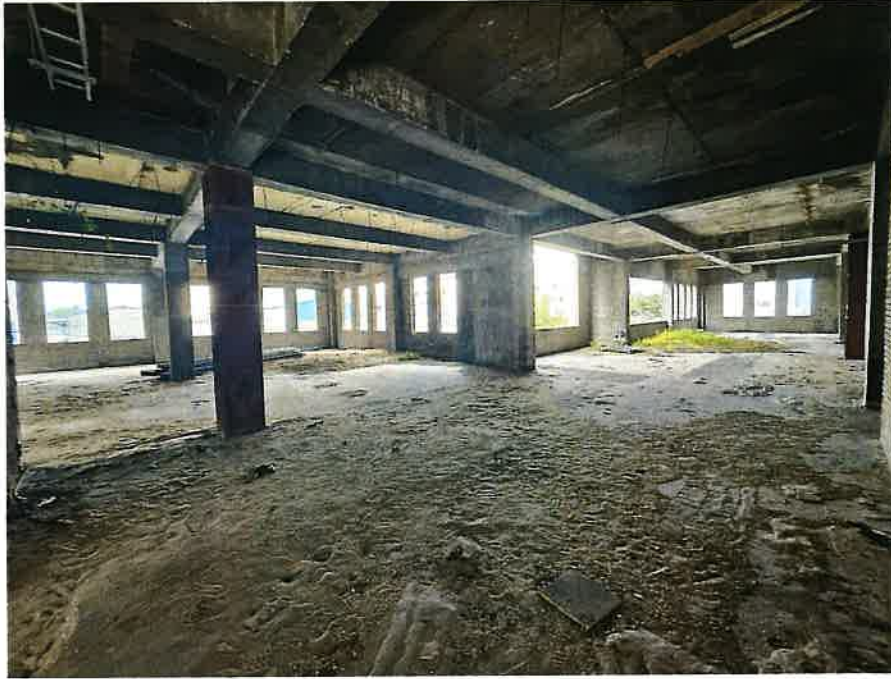
본건 건물 2층 내부전경
