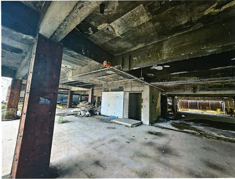
본건 건물 1층 내부전경
