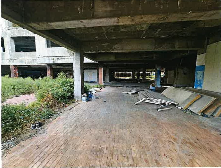
본건 건물 1층 내부전경
