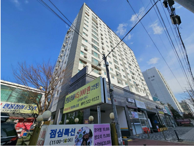
[본건 전경] 본건 남서측에서 촬영
