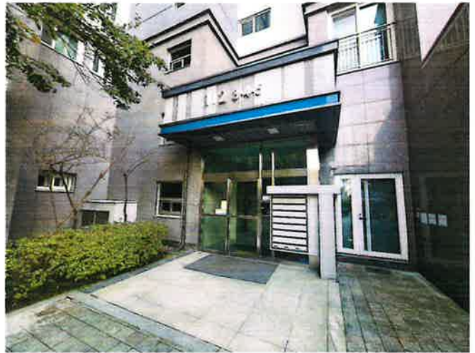
기호(가) 1층 공동 출입구 전경
