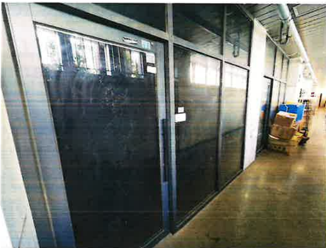
기호(나) 후면 출입구 전경
