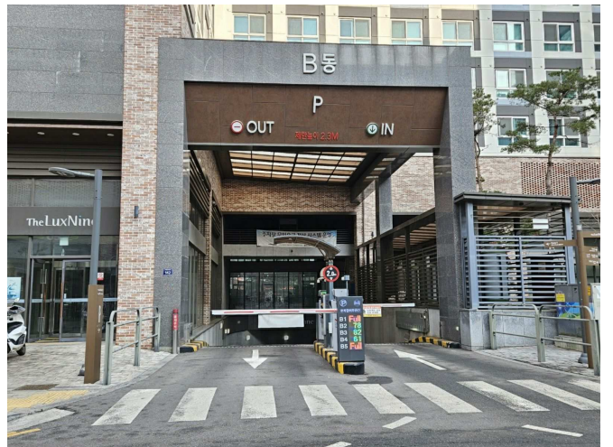
[지하 주차장 출입구]
