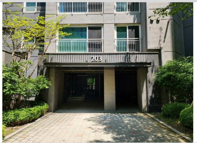
1층 출입구 전경
