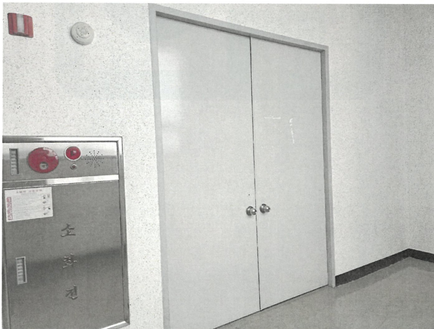
대상호수(603호) 출입문 전경
