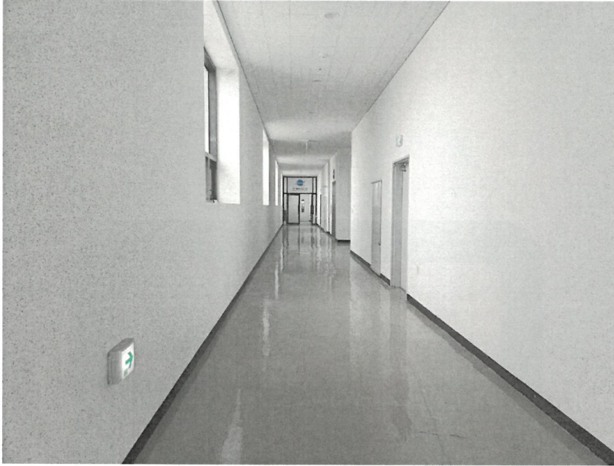
6층 복도 전경
