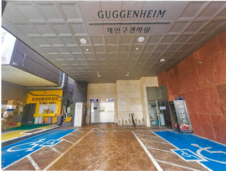
[기계식 주차 및 공동출입구]
