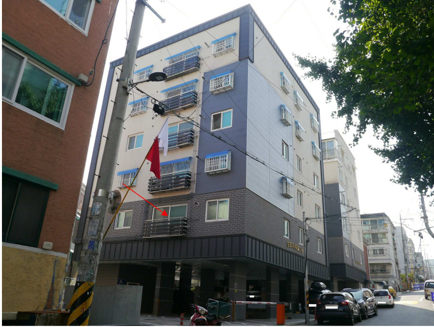
본건(성도리치빌 나동 2층 203호) 전경(북서측에서 촬영)
