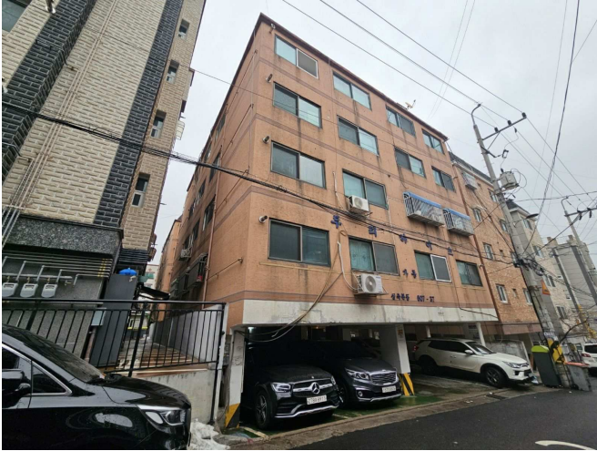
[본건 전경] 본건 남서측에서 촬영
