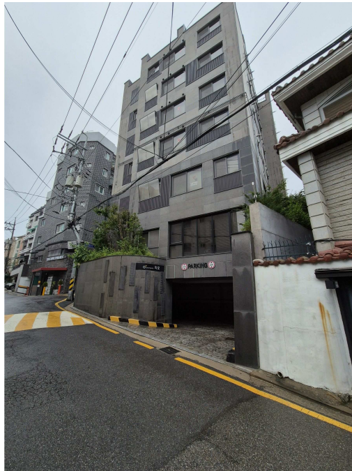
본건(성산지오) 남서측 부위 전경
