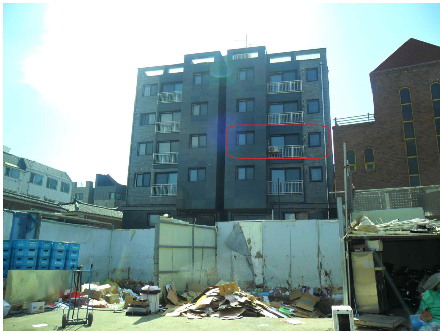
대상물건 전경 (북서측에서 촬영)
