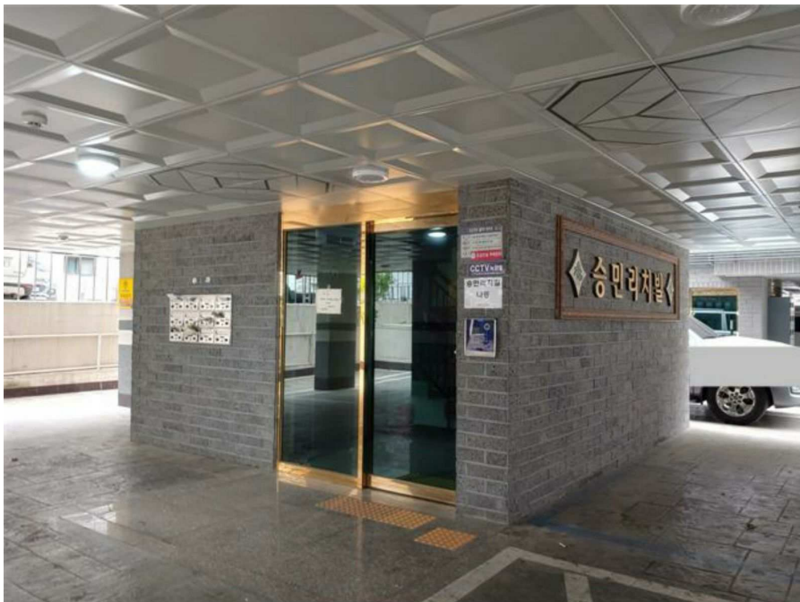
1층 공용출입구 전경
