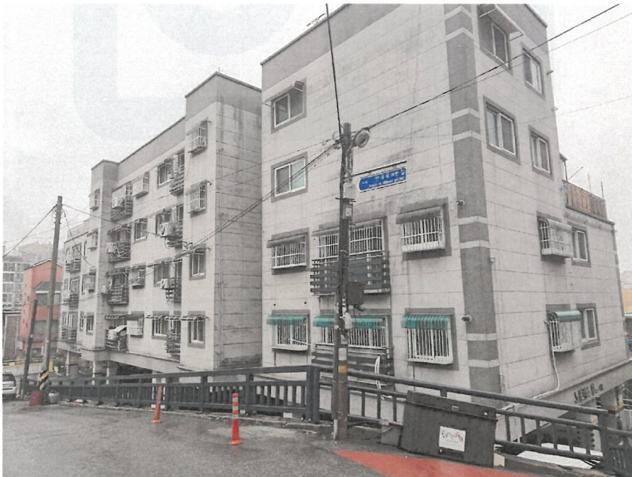
남서측 인근에서 촬영한 연접한 동(가동) 및 본동(나동) 전경
